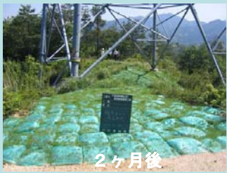
施工完了1ヶ月後
