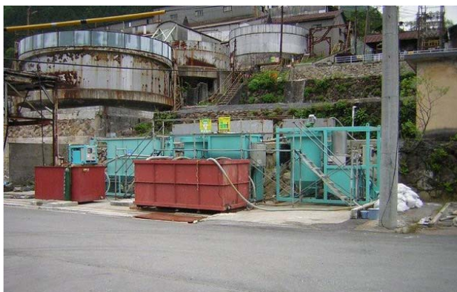
装置の設置状況
