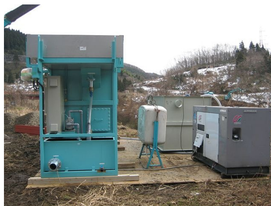
装置の設置状況
