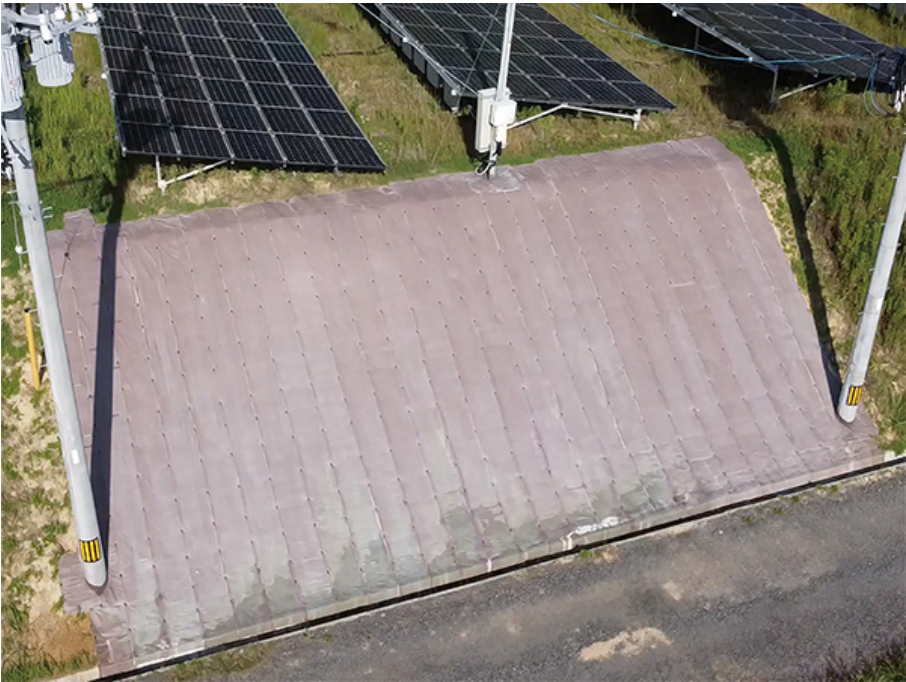
ドライマットを使用した法面保護工
