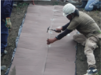
アンカーピン打設状況
