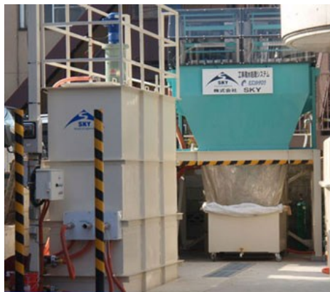
中間脱水処理設備設置状況
